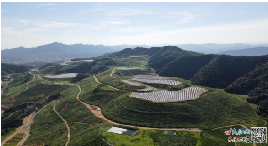
2022年西部排土场生态修复后一片盎然生机（图片来源于江西省自然资源厅）
