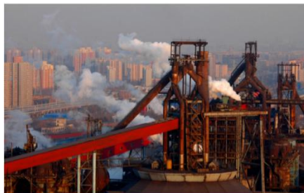
生产时期的首钢老厂区
