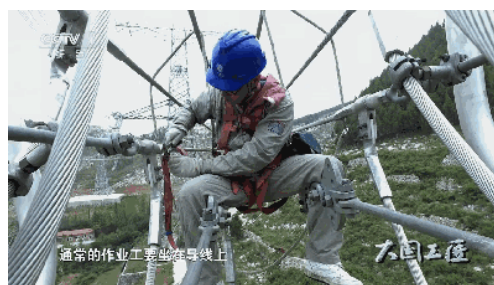
图2 特高压线上的带电检修工王进
