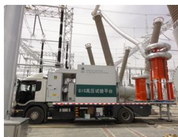
图5 高压耐压测试
