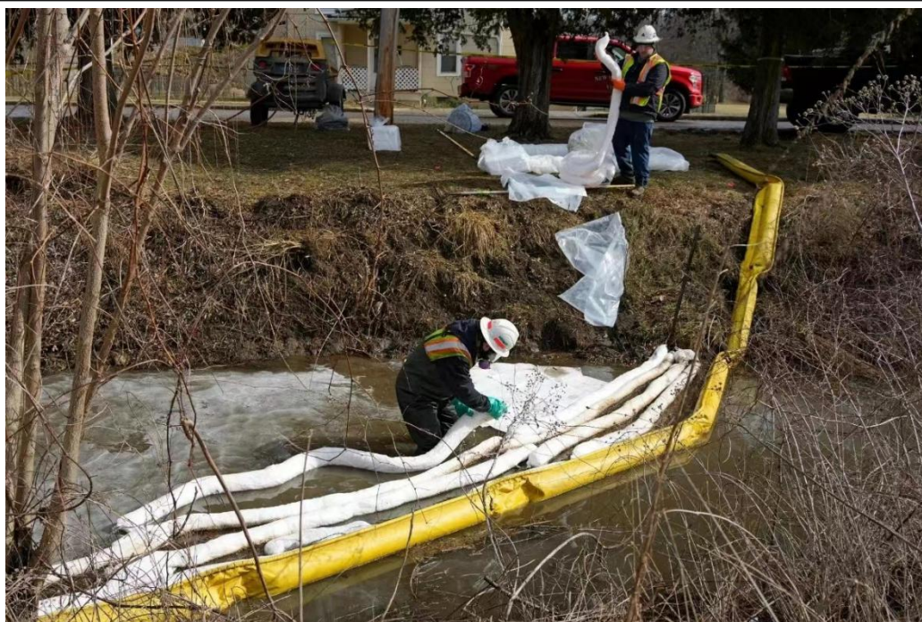
图 1 环保工作者在火车脱轨地点附近的溪流中放置拦油栅
