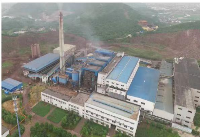
图 5 绍兴市污泥和垃圾焚烧发电工程
