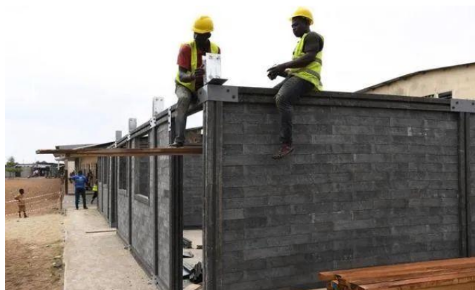
图 2 废塑料制备的砖头
