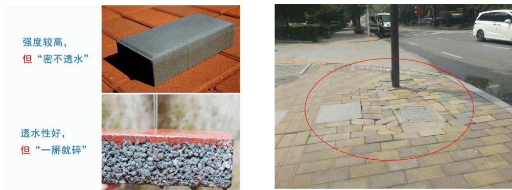
图 1 传统透水砖透水性和强度存在矛盾 图 2 仅 1 年的普通透水砖路面
