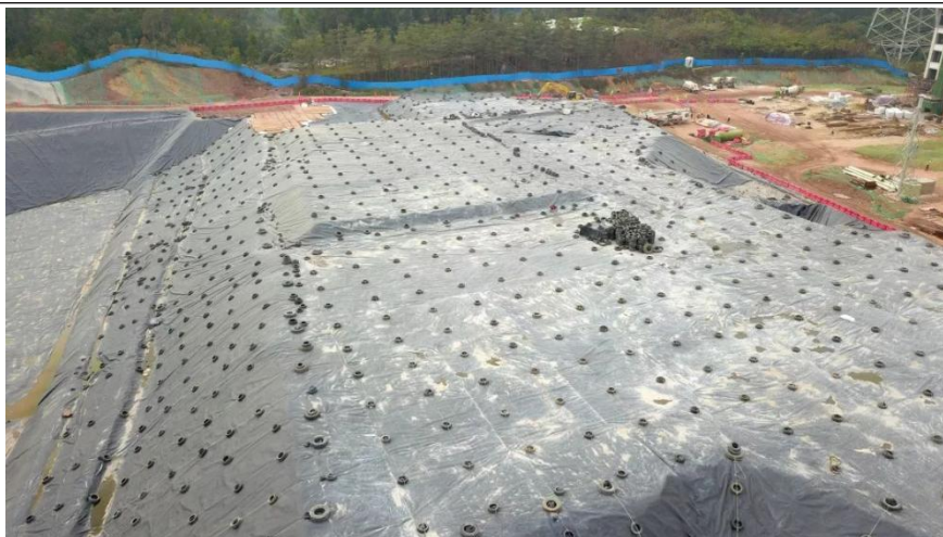
图 4 填埋场 A 库区依法安全填埋飞灰螯合物
