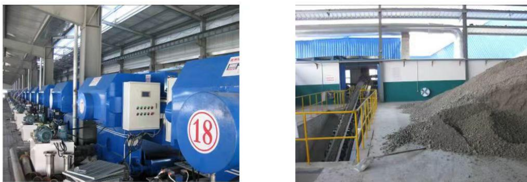
图 3 杭州富阳八一污水处理厂污泥脱水焚烧处理工程
