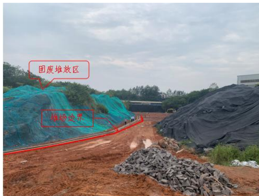
图 2 固废堆场现状
