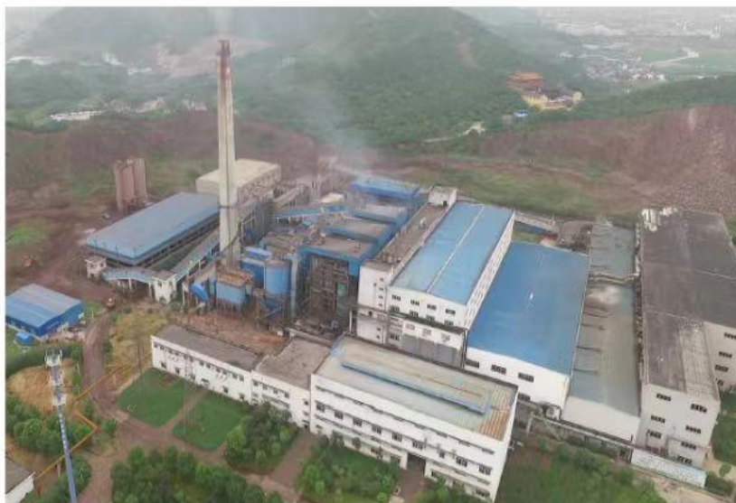
图 5 绍兴市污泥和垃圾焚烧发电工程
