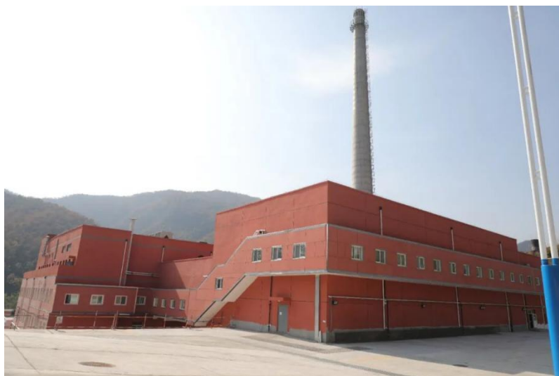
图 6 废液水泥玻璃固化处理设施
