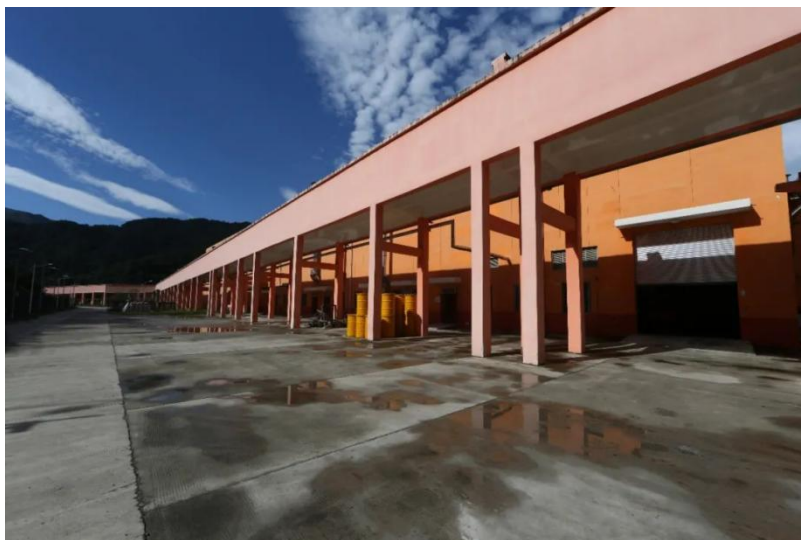
图 5 废液水泥固化处理设施
