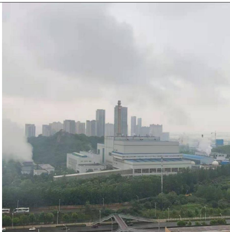
图3 垃圾焚烧现场——烟雾直接飘进居民区
